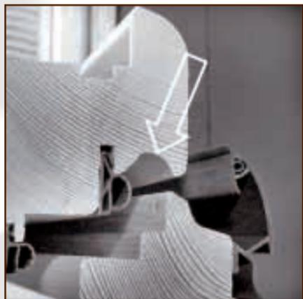
Il rompigoocia come già il nome lascia intuire è una cavità presente lungo tutto il perimetro dell'anta che per la forma particolare impedisce che l'acqua per effetto anche della turbolenza dell'aria formi una pellicola continua (il cosiddetto "ponte") fino alla guarnizione che in questo contesto non ha funzione di tenuta all'acqua ma permette alle gocce di acqua che superano la barriera
