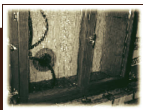
Le prove di tenuta effettuate sulla finestra Danese.
